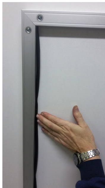
pěchování těsnění z rubové strany
